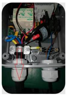
▶ 将需要安装的充电枪按照拆卸步骤反向操作将充电枪安装到机器里面,注意更换 后枪线颜色、CP线接线位置与拆卸前是一致。
